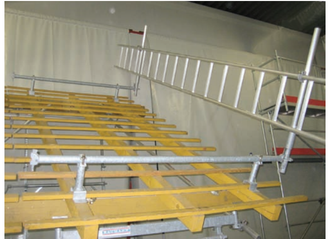
Bild oben: Ausführung mit Gerüstleiter (in Verbindung mit einer Normalkupplung), Pfostenabstand 5,0 m
