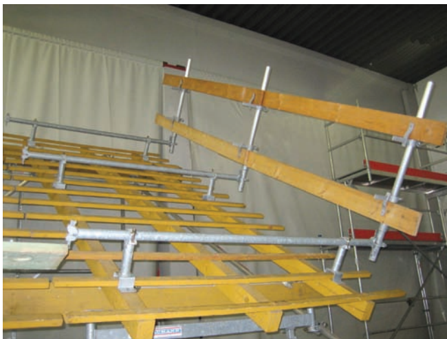
Bild oben: Ausführung mit Gerüstleiter (in Verbindung mit einer Normalkupplung), Pfostenabstand 5,0 m
